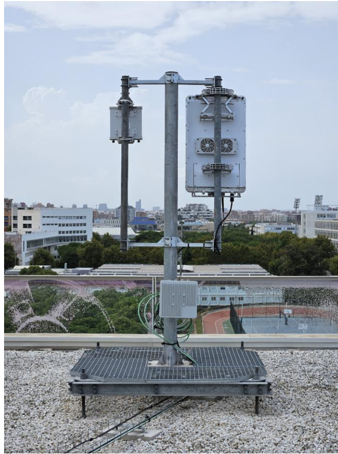
Figura 2 – Unidad de radio Benetel 650 (parte inferior) y antena pasiva (izquierda superior).
